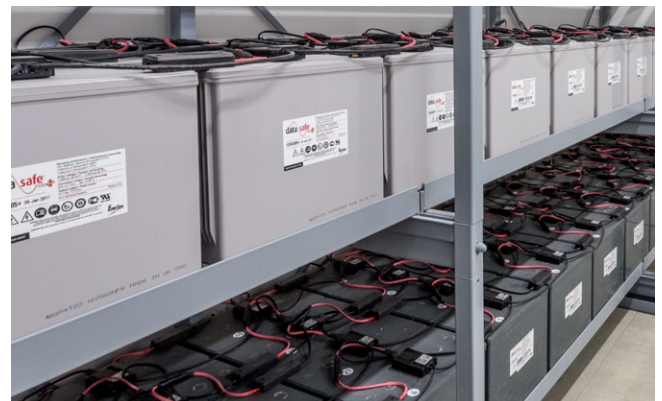
Batterien für eine unterbrechungsfreie Stromversorgung
