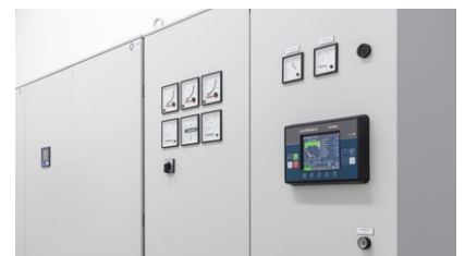
Energieeffizienz/Verbrauch: PUE 1,15 bei Vollaustlastung
