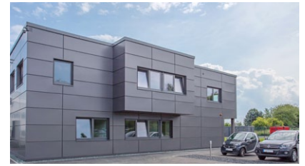
Bürogebäude: 250m 2 für eigene Techniker und Administratoren
