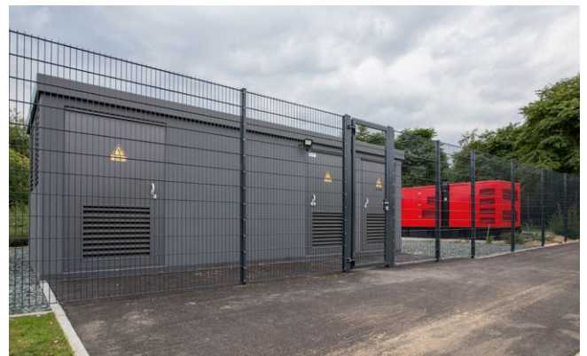
Trafostation und Generator
