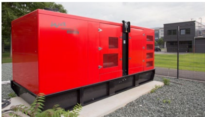
Dieselgeneratoren: 15.000L Kraftstoffvorrat
