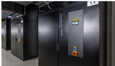
Klimatechnik: Direkte freie Kühlung, maximale Effizienz
