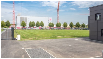
Grundstücksgröße: 8.000m 2 Grundstück, Platz für mehrere RZ-Gebäude
